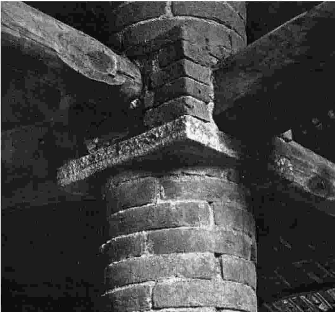
Interno Fabbrica Viotti
