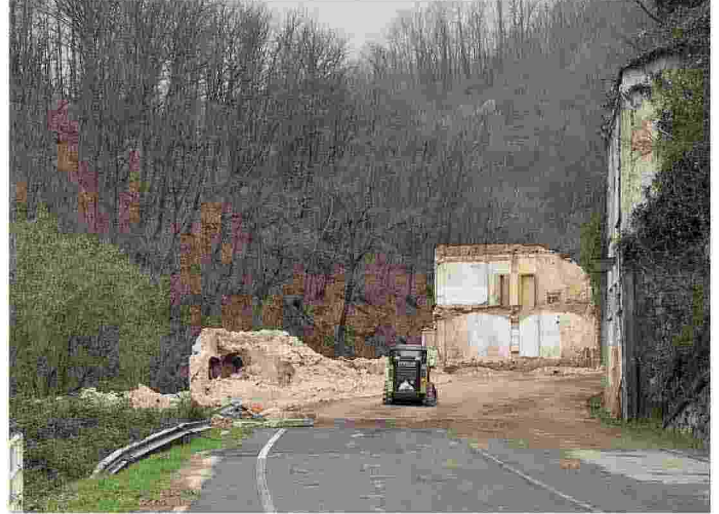
Opificio demolito sul torrente Strona
